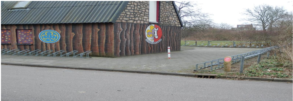
Fietsenrekken naast het gebouw
